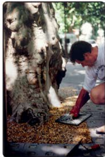
Mortier de résine EUROFIX H® (1kg) + Agrégats (25kg) = Dalle filtrante (300l/mn/m²)
