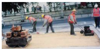
Découper, éventuellement Nettoyer & compacter la surface
