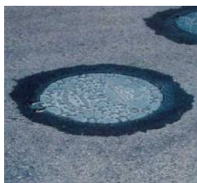
Nettoyer éventuellement le trou à combler
