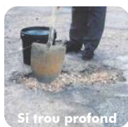
Si trou profond Comblé avec de la pierraille puis compacter
