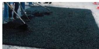
Remplir avec RESI'SOLDUR Etaler à l'aide d'un râteau
